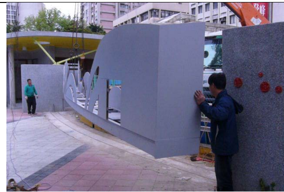
台車測試一吊裝
