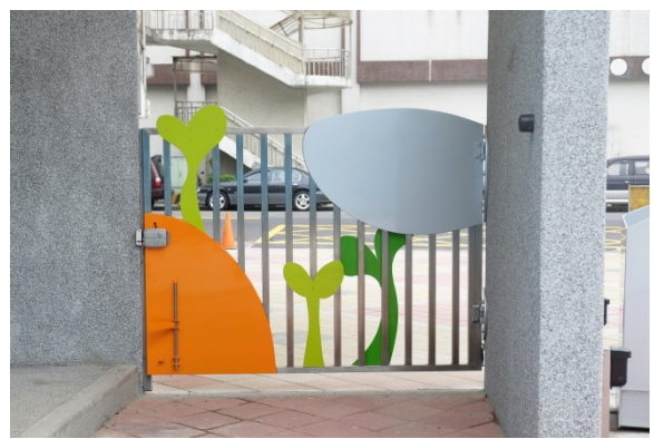
小門安裝完成—背面
