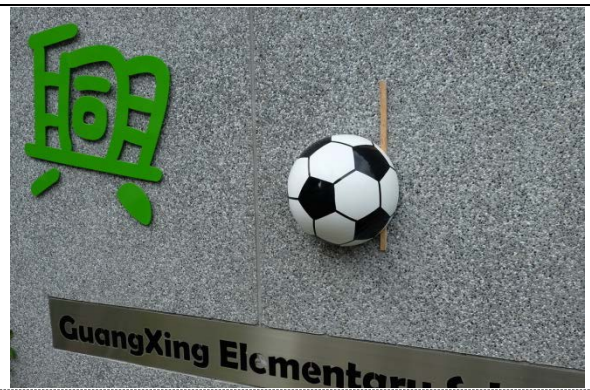
英文字、不鏽鋼足球安裝完成
