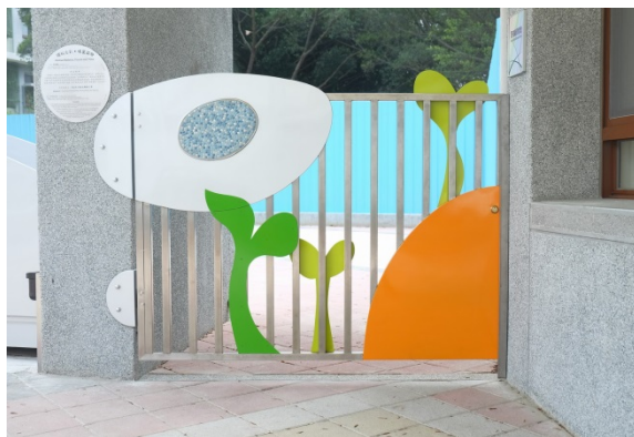
小門安裝完成—正面
