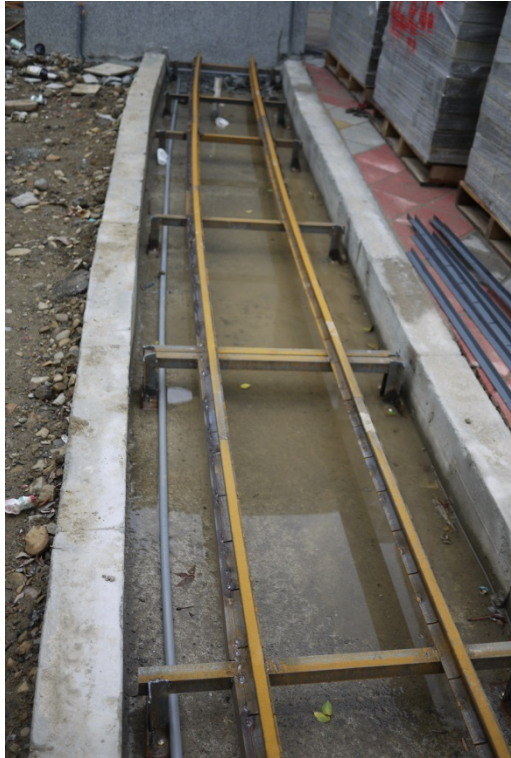
軌道鋪設完成
