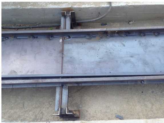
軌道焊接及固定—細部
